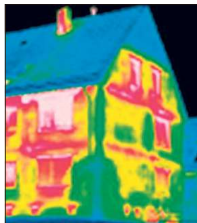
Energetische Schwachstellen deckt eine Wärmebildkamera auf.
